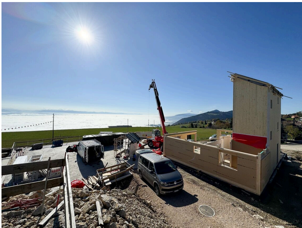
Vue sur le bâtiment A
