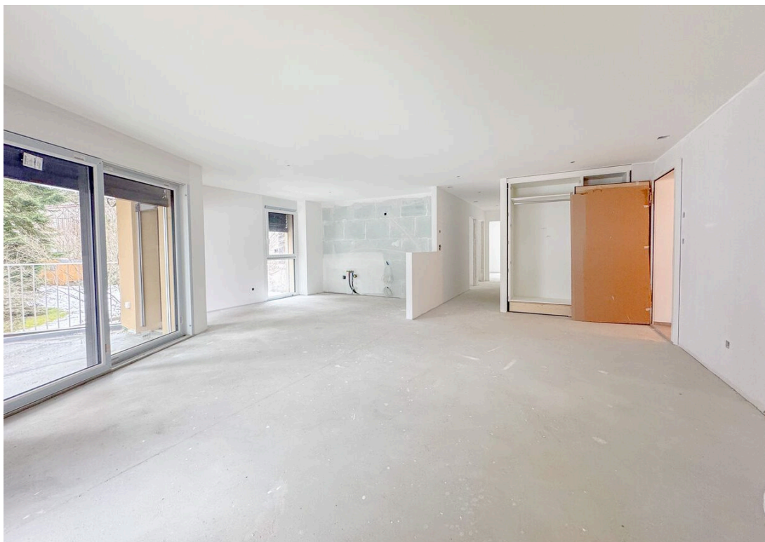
Cuisine et séjour en cours de travaux.
