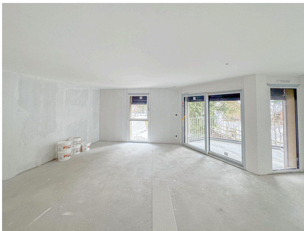
Séjour et balcon en cours de travaux
