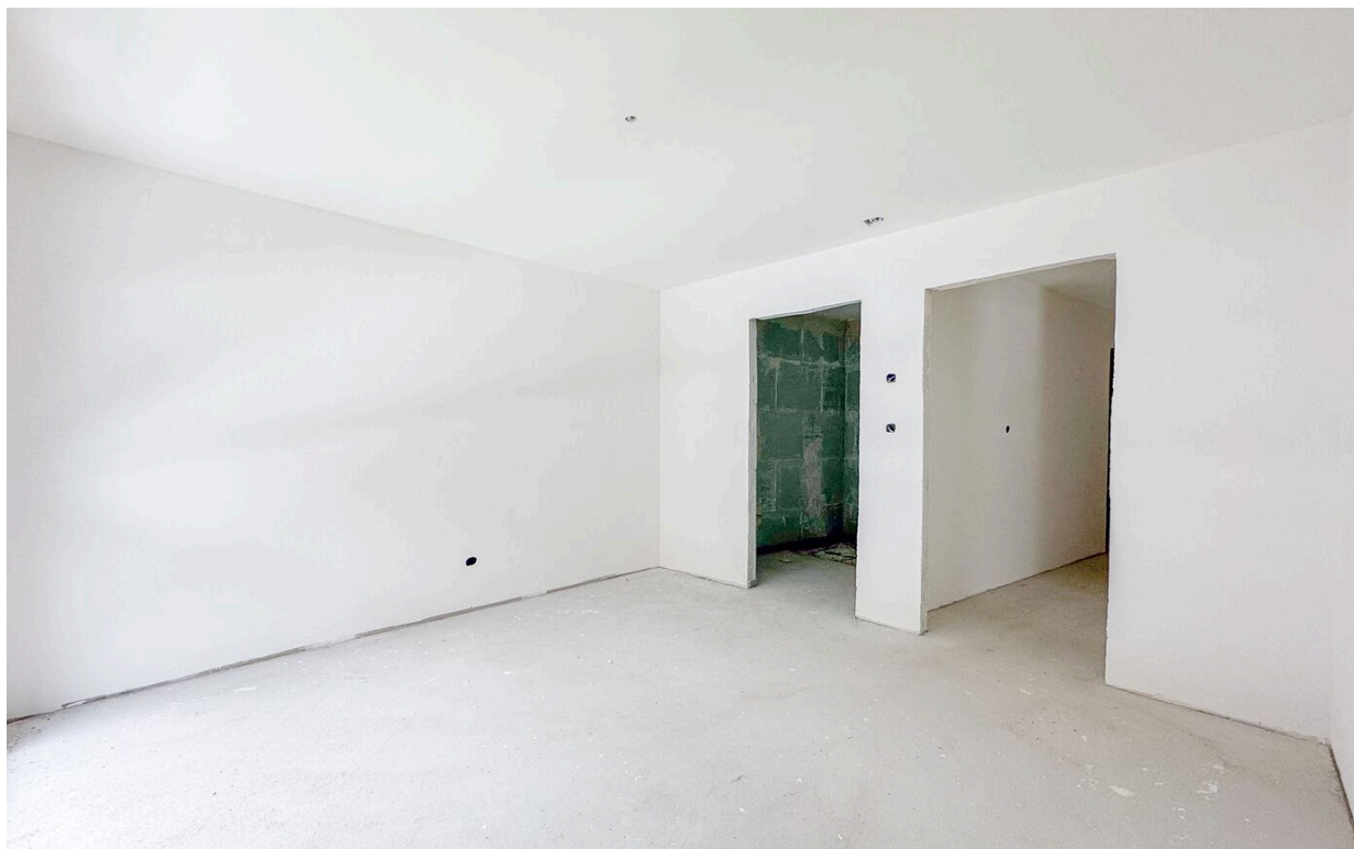
Chambre parentale en cours de travaux.
