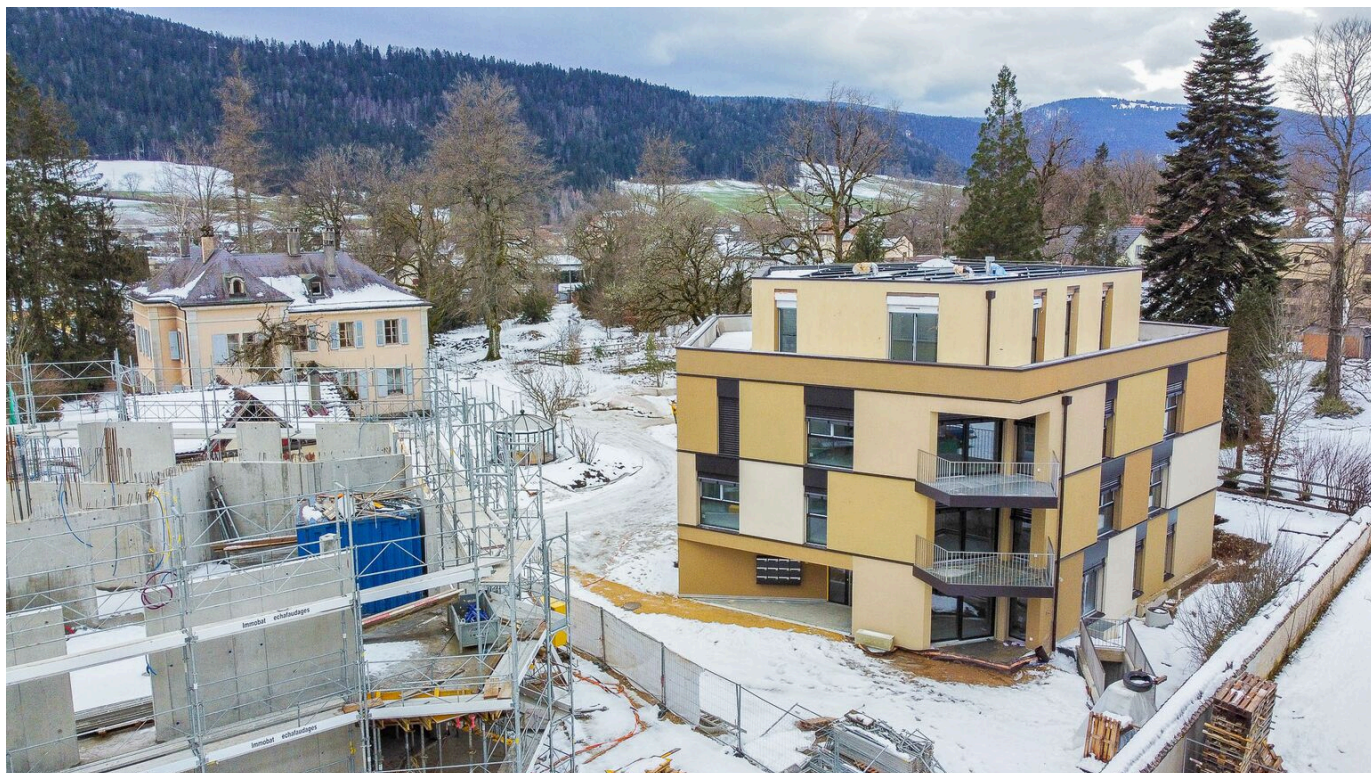
Vue aérienne sur le bâtiment A et le bâtiment B en construction
