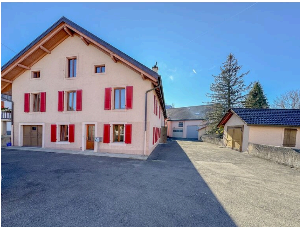
Vue sur la maison et le garage
