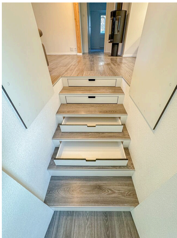
Logement - accès par les escaliers avec tiroirs de rangement
