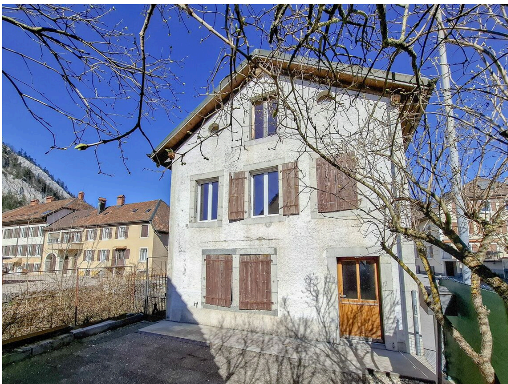
Vue sur la maison et la terrasse
