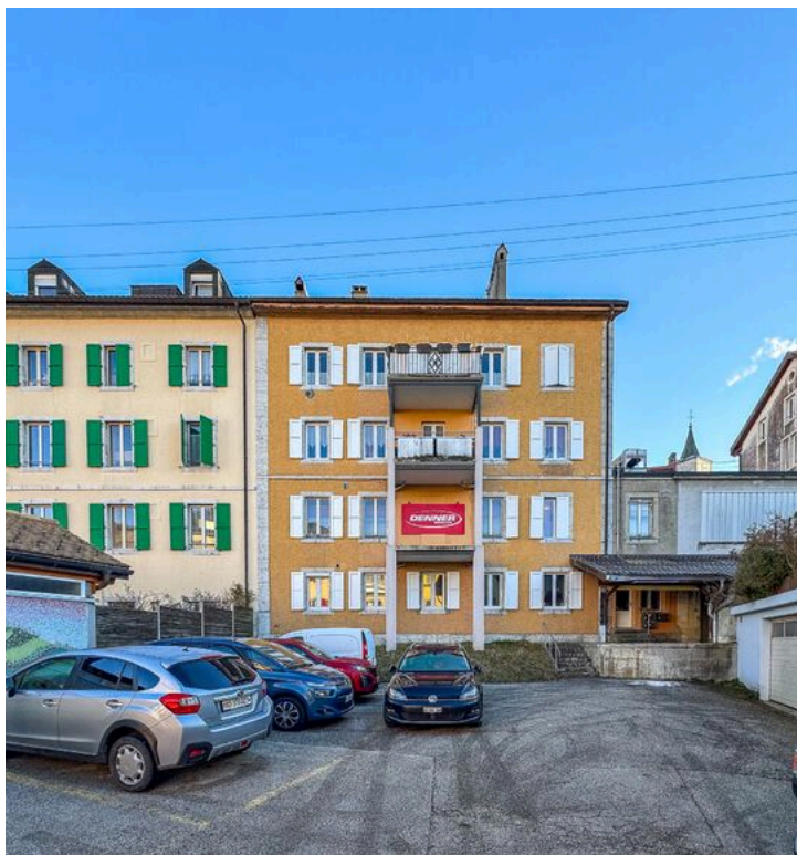
Parking et accès aux logements - Rue Neuve
