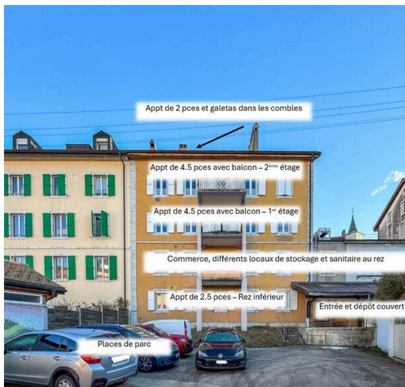
Vue sur le bâtiment - Rue Neuve
