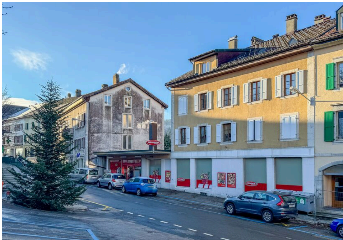
Vue sur le bâtiment - Rue Centrale
