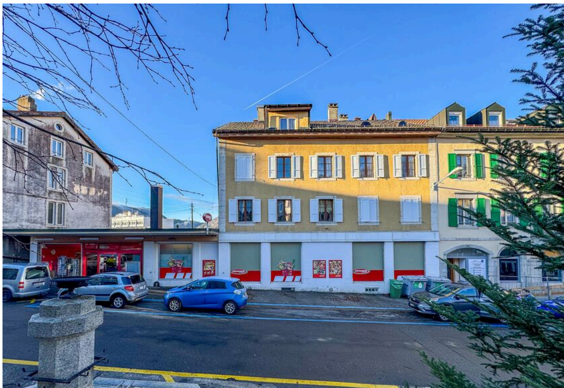
Vue sur le bâtiment - Rue Centrale
