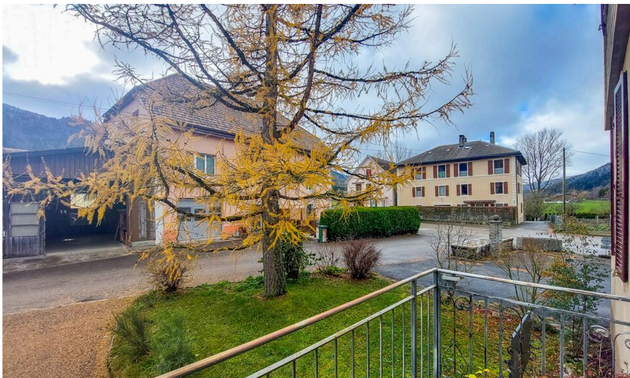
3.5 pces au rez-de-chaussée au Sud-Ouest : balcon exposé Sud
