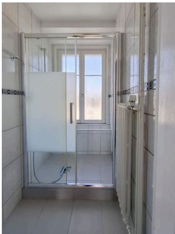
Appartement au 1er étage vacant - salle d'eau avec douche
