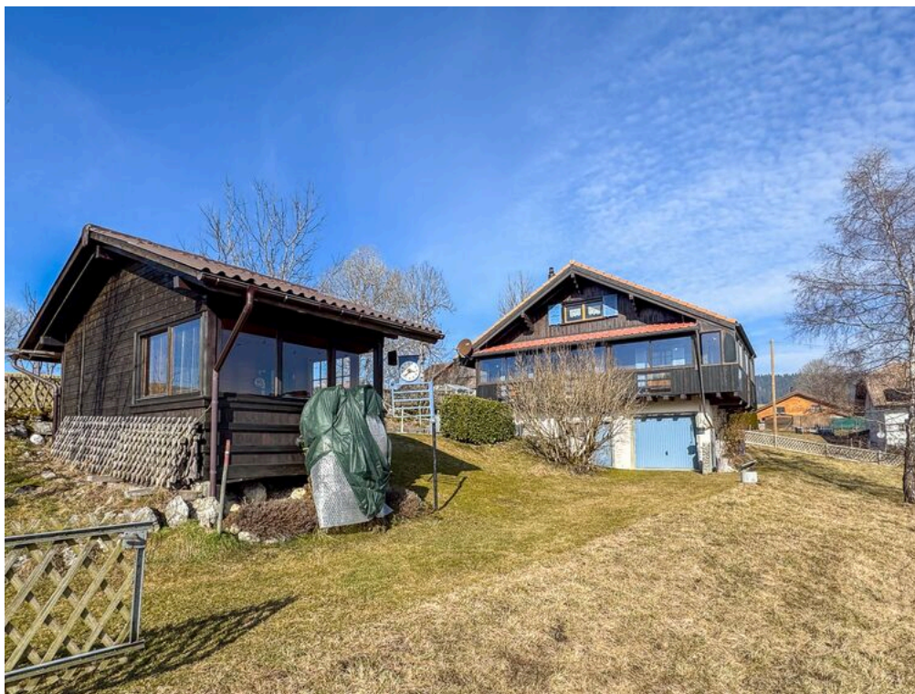
Vue sur le chalet et le pavillon de jardin
