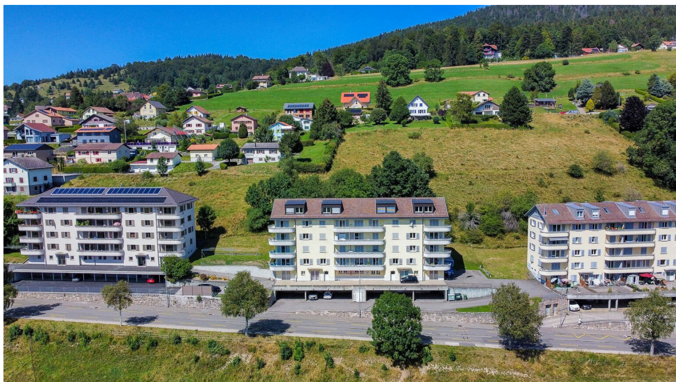
Vue aérienne du bâtiment
