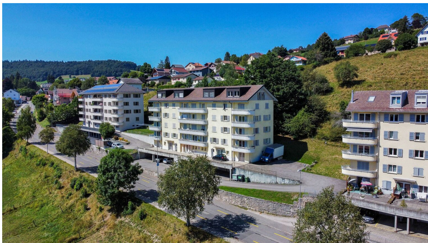
Vue aérienne du bâtiment
