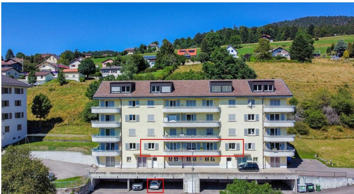
Vue aérienne du bâtiment
