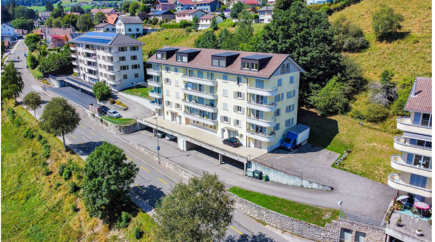
Vue aérienne du bâtiment
