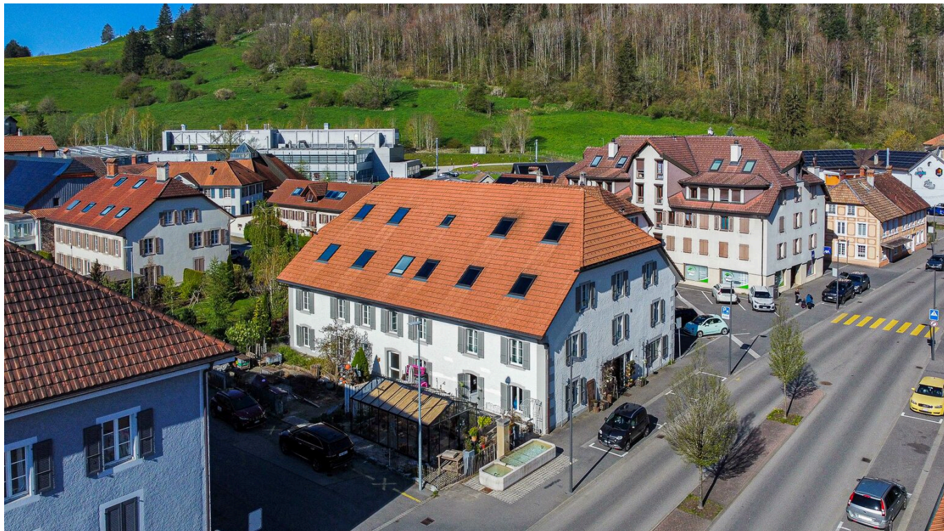
Vue aérienne du bâtiment
