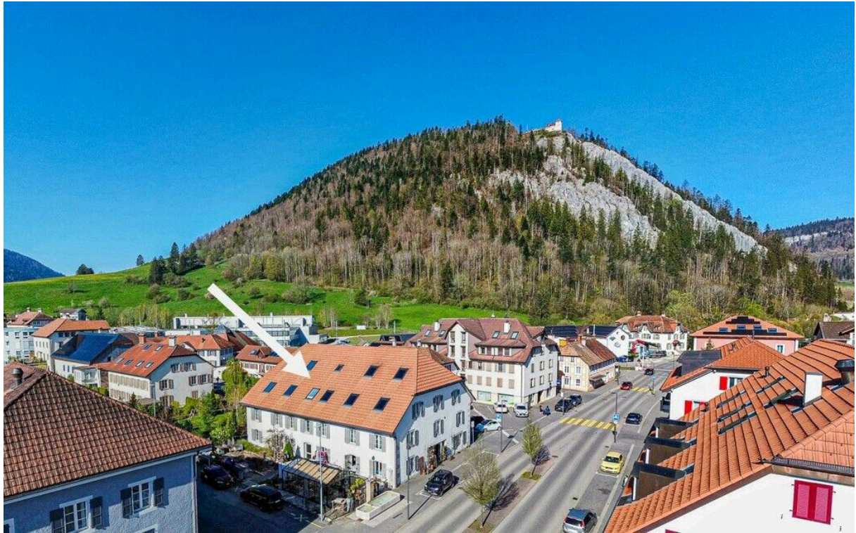
Vue aérienne du bâtiment
