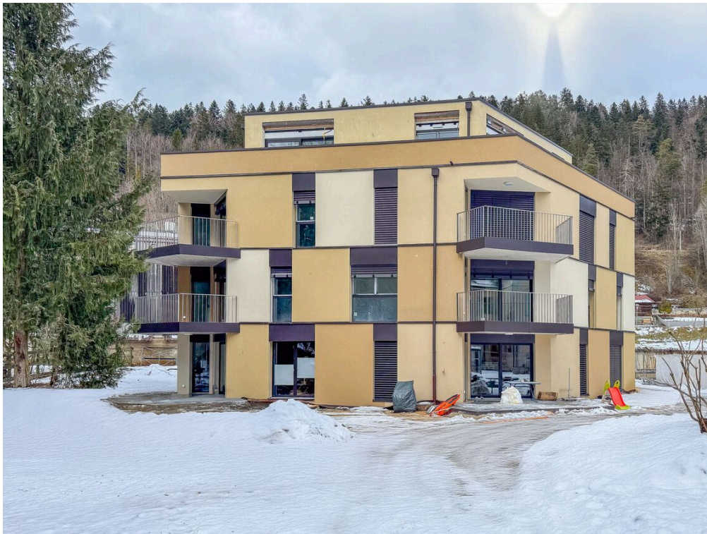
Vue sur le bâtiment
