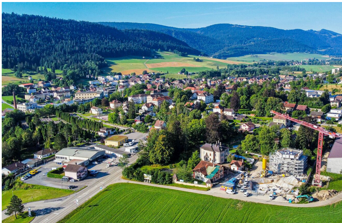
Vue aérienne sur le Val-de-Travers et le chantier
