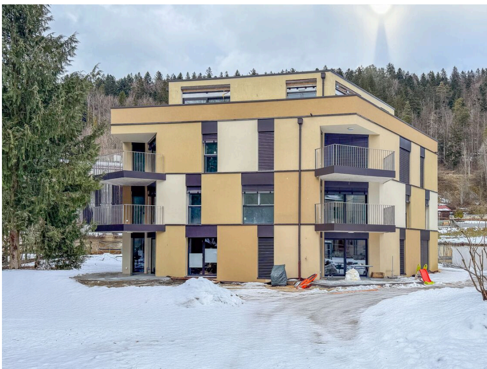
Vue sur le bâtiment A
