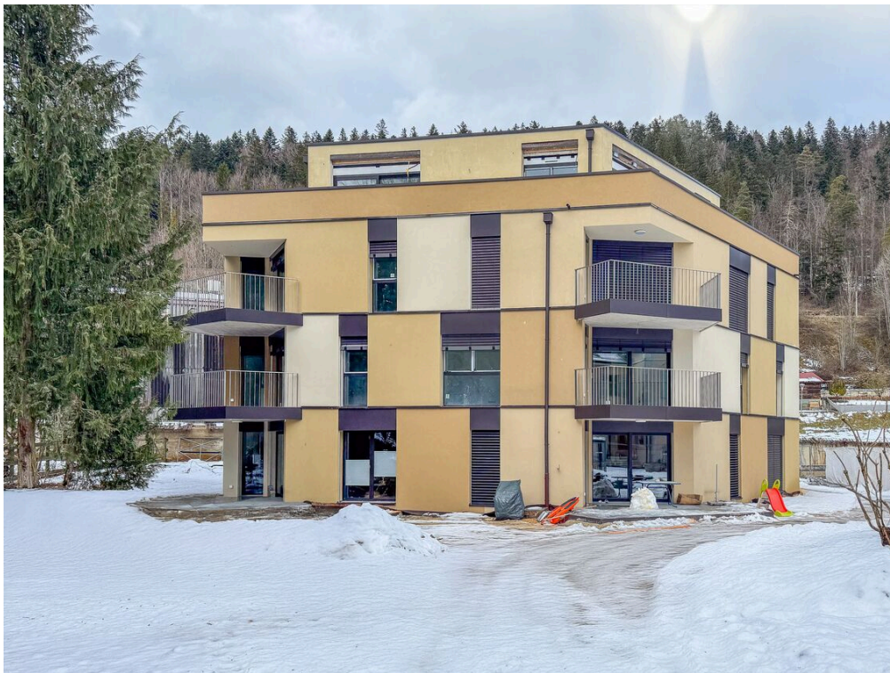
Vue sur le bâtiment A
