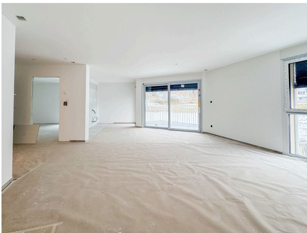
Cuisine et séjour du lot A1 en cours de travaux (équivalent au bâtiment B)
