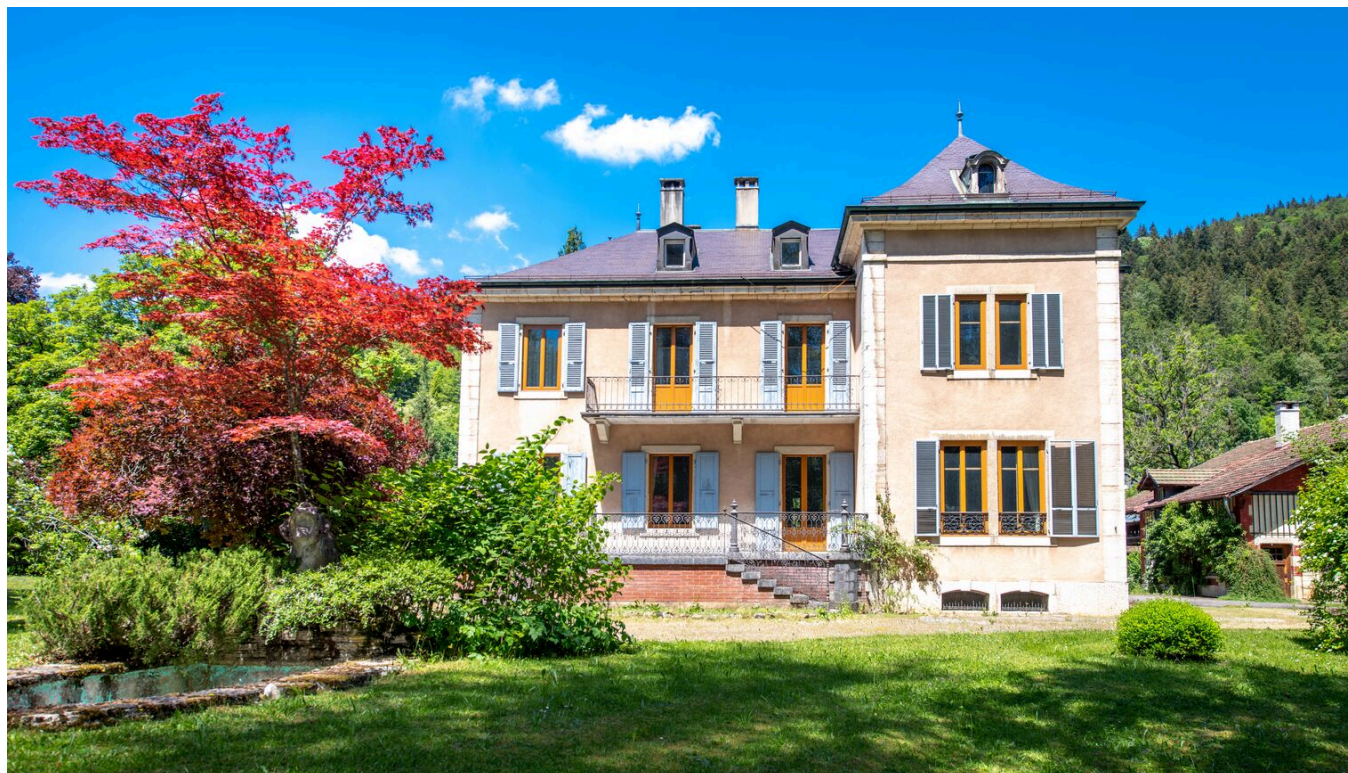
Cadre d'exception avec une maison de maître en toile de fond
