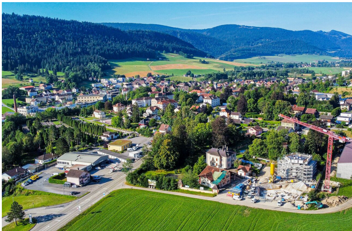
Vue aérienne sur le Val-de-Travers et le chantier
