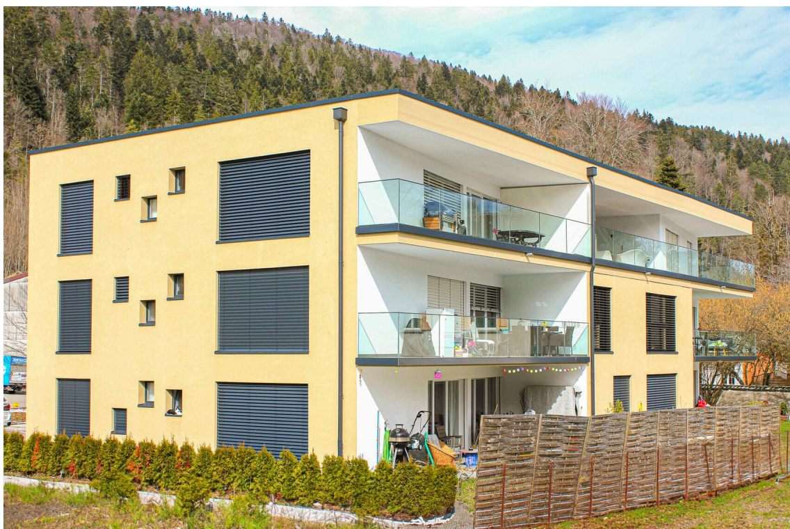
Vue sur le bâtiment
