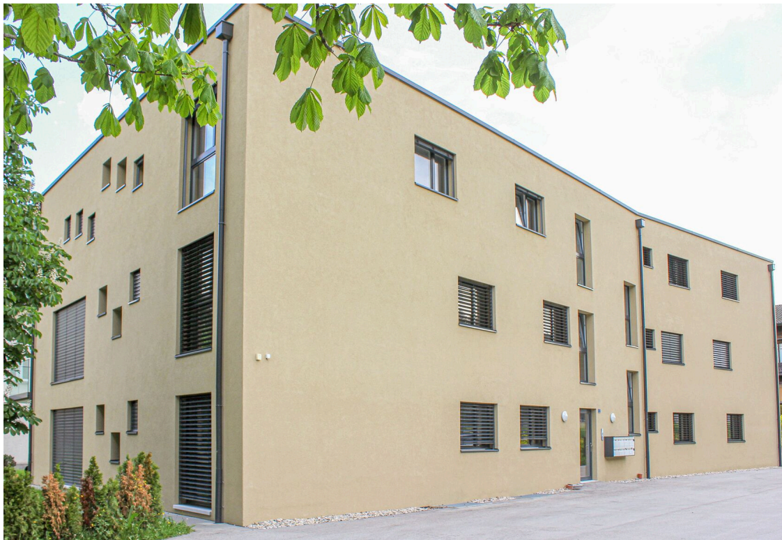
Vue sur le bâtiment
