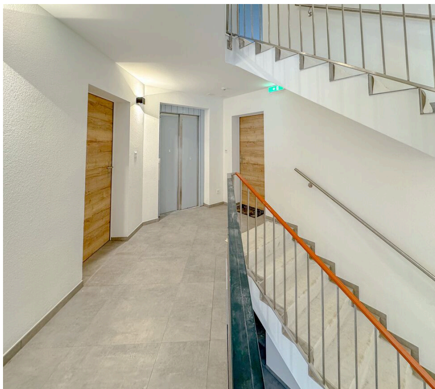
Communs bâtiment A
