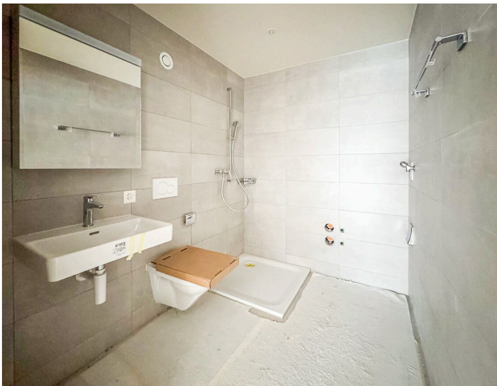
Salle de douche du lot A1 en cours de travaux
