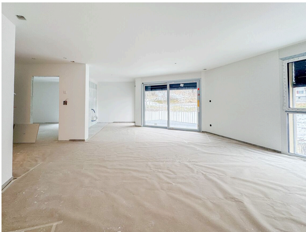
Cuisine et séjour du lot A1 en cours de travaux (équivalent au bâtiment B)
