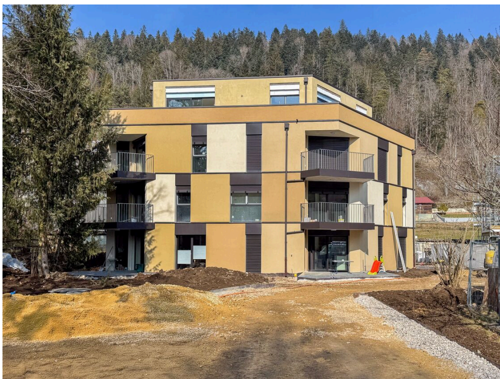
Vue sur le bâtiment A
