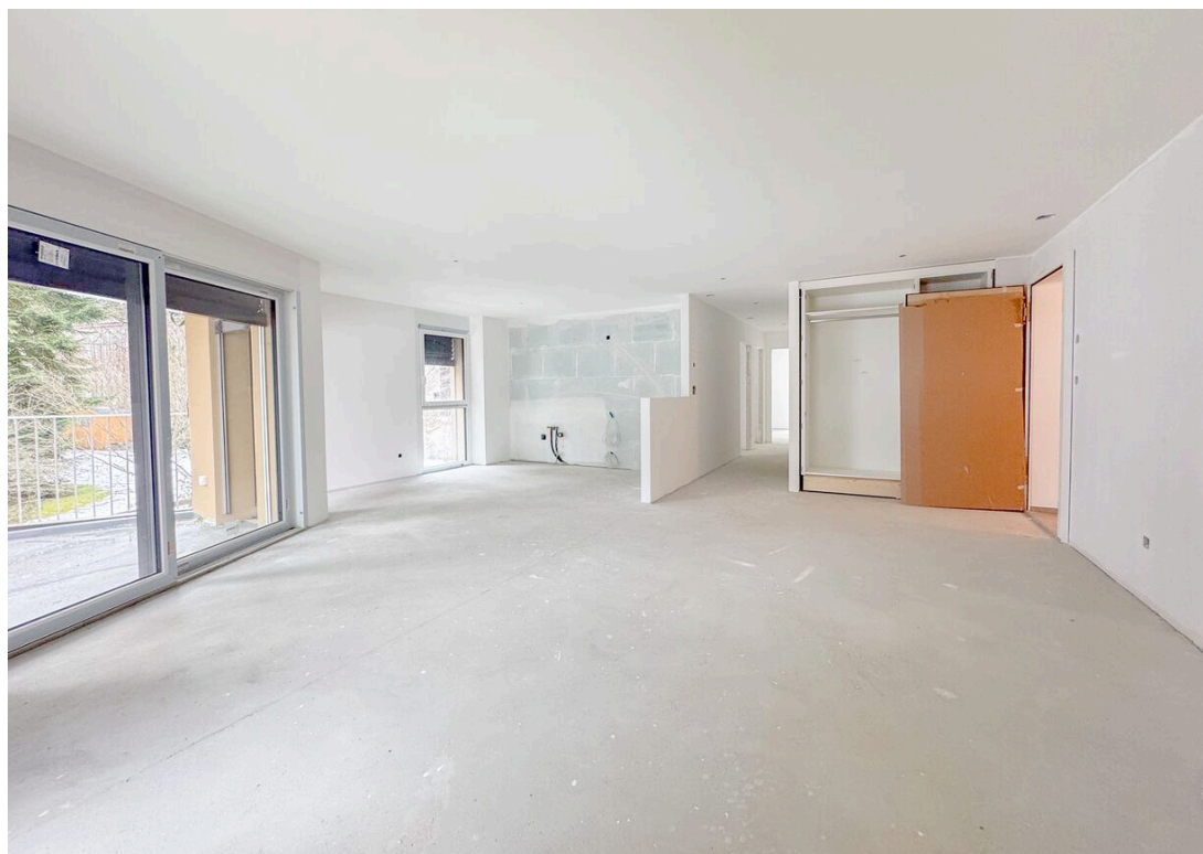
Cuisine et séjour en cours de travaux.
