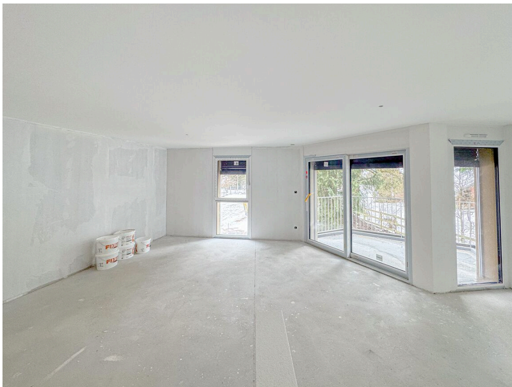
Séjour et balcon en cours de travaux
