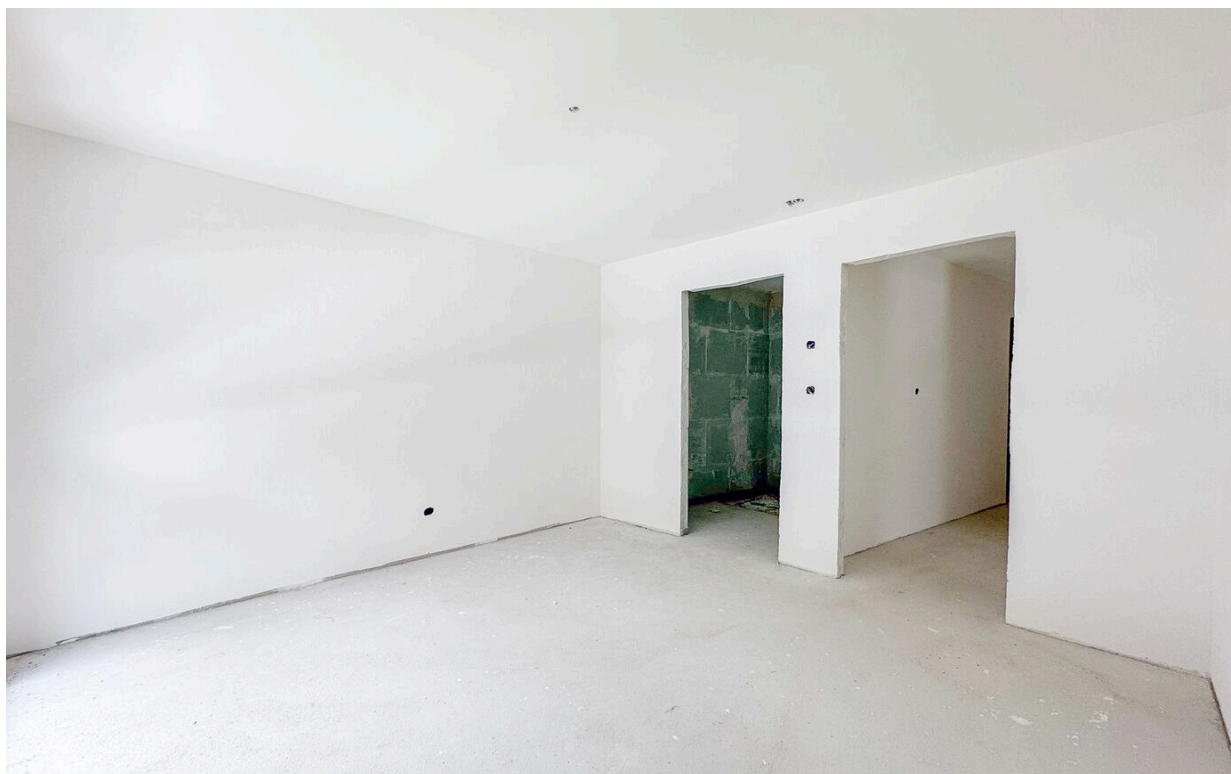
Chambre parentale en cours de travaux.
