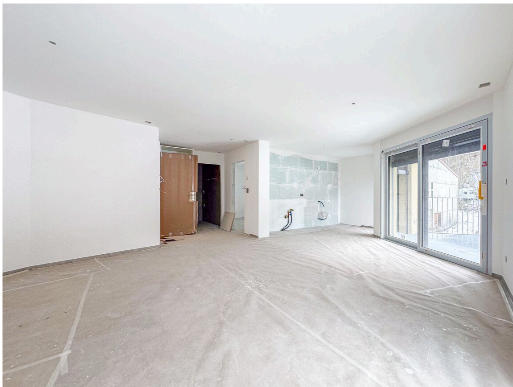
Cuisine et séjour en cours de travaux
