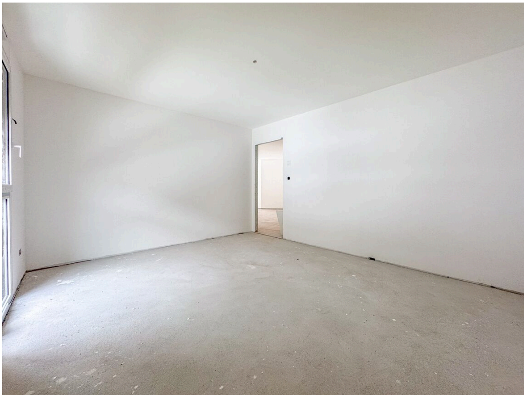
Chambre du lot A1 en cours de travaux
