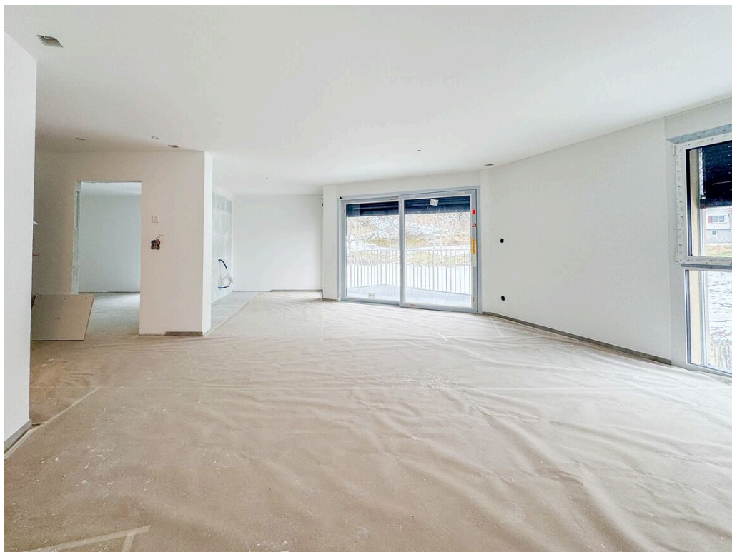
Cuisine et séjour du lot A1 en cours de travaux
