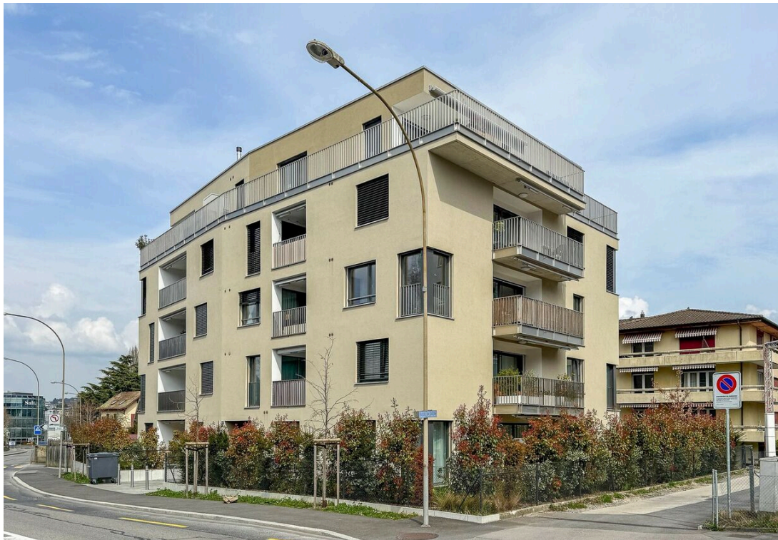
Photo du bâtiment
