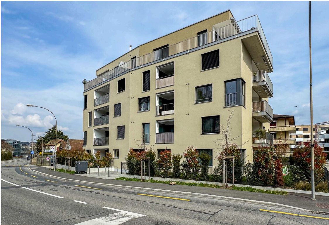
Vue sur le bâtiment
