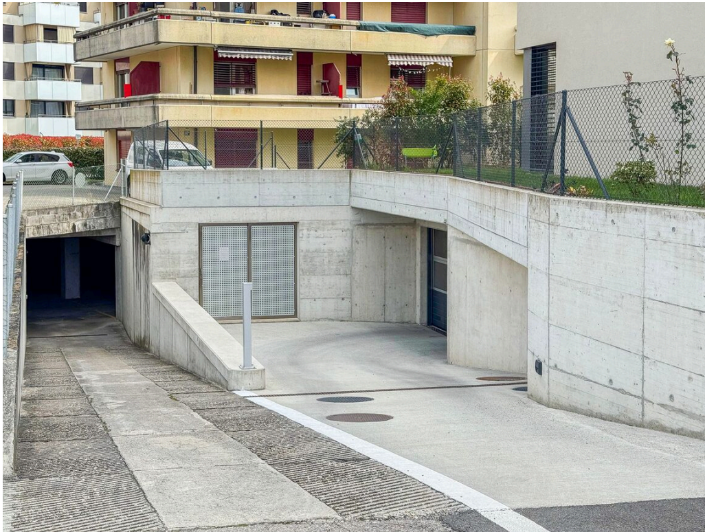
Accès au parking souterrain
