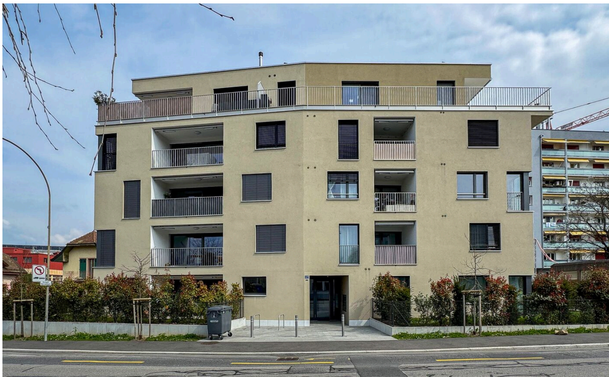
Vue sur le bâtiment
