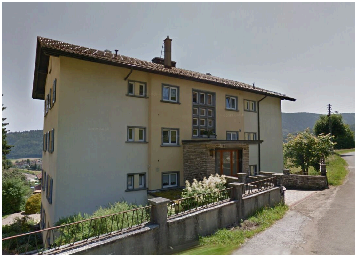
Immeuble, côté rue Gittaz
