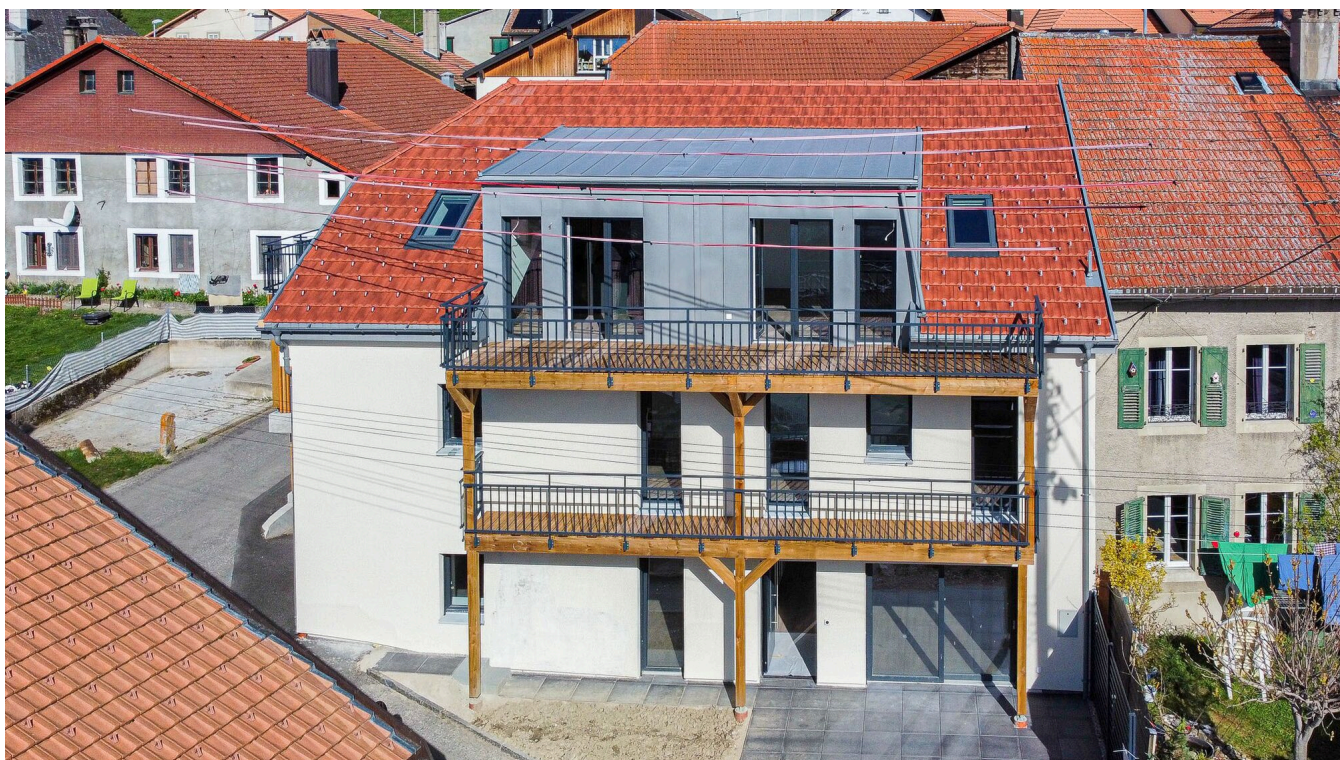
Vue aérienne - façade Sud
