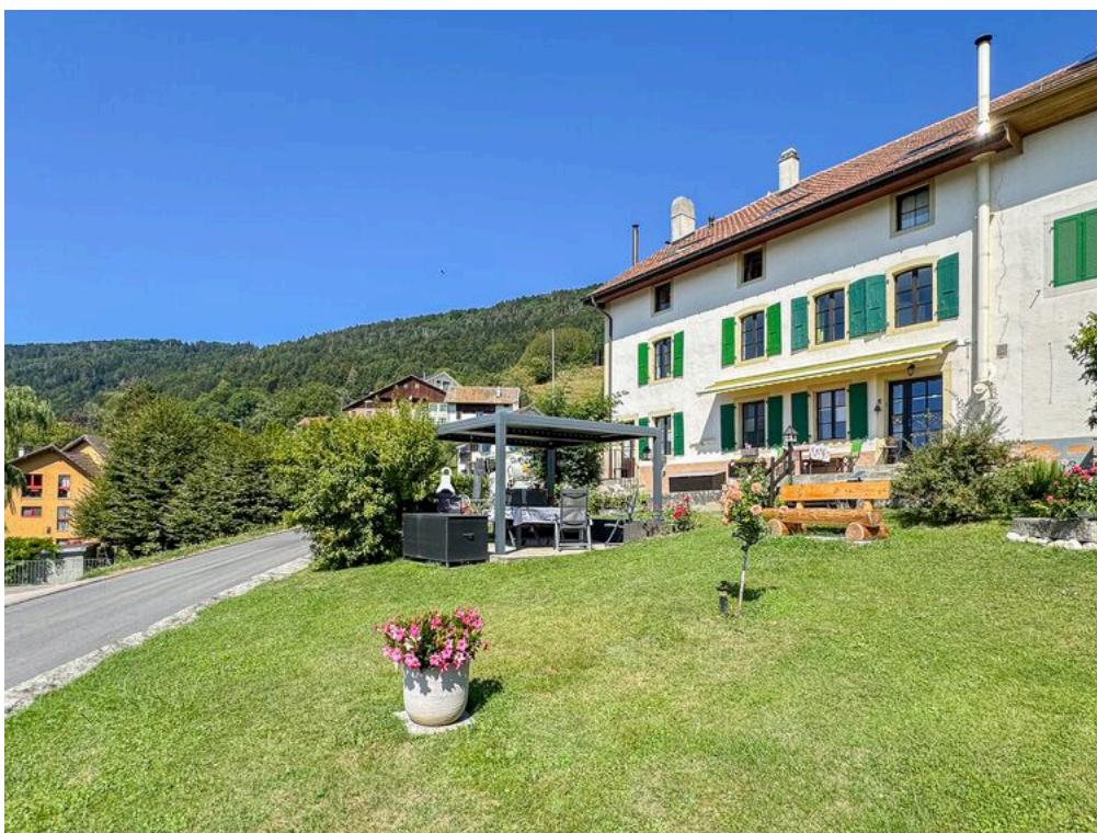
Vue sur la façade Sud, le jardin et la pergola
