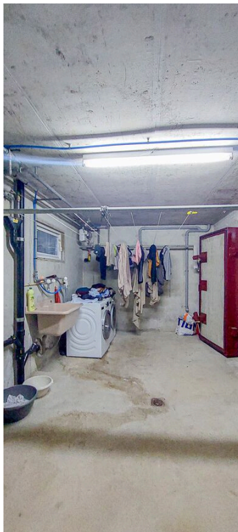
Buanderie au sous-sol
