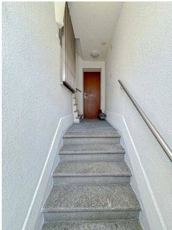
Communs de l'immeuble
