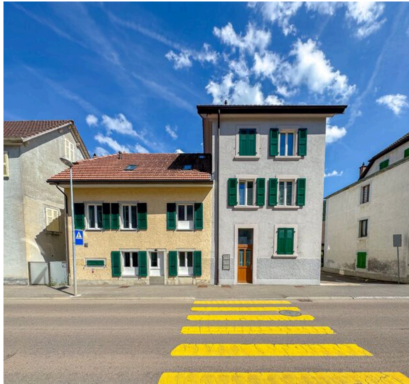
Vue sur la maison mitoyenne et les appartements
