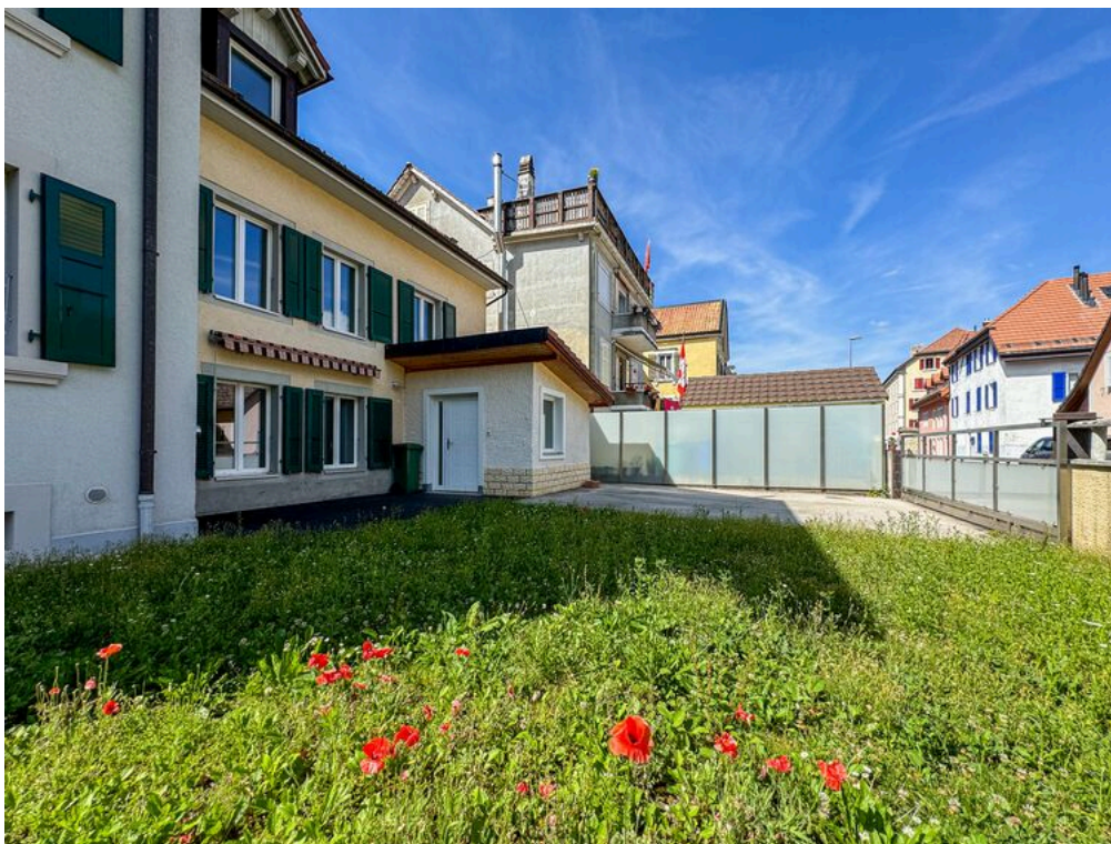
Jardin avec entrée (portail électrique)
