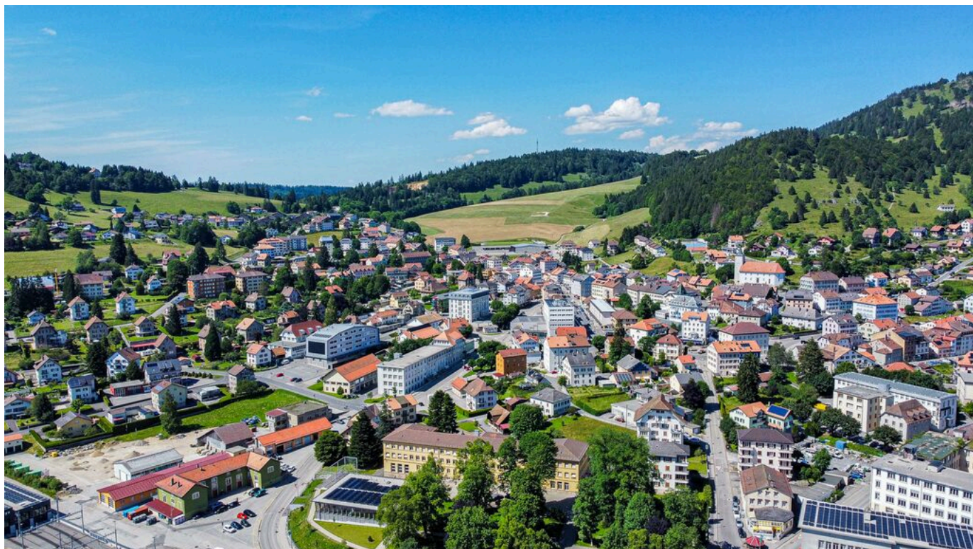
Vue aérienne de Ste-Croix
