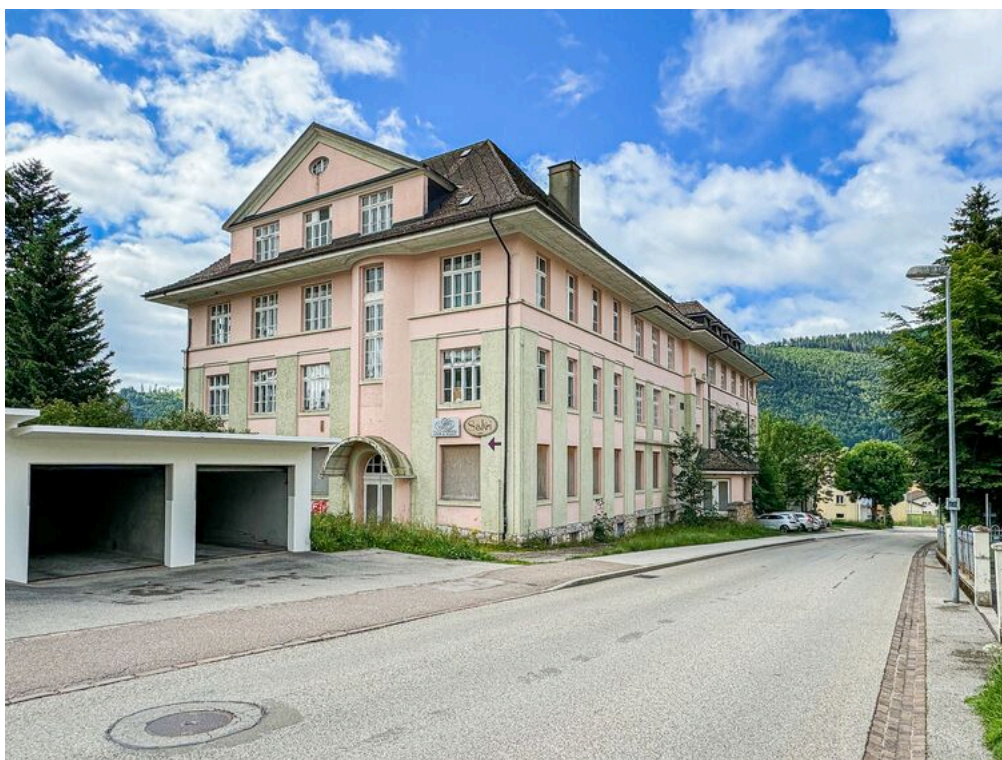
Vue du bâtiment, faces Nord-Ouest
