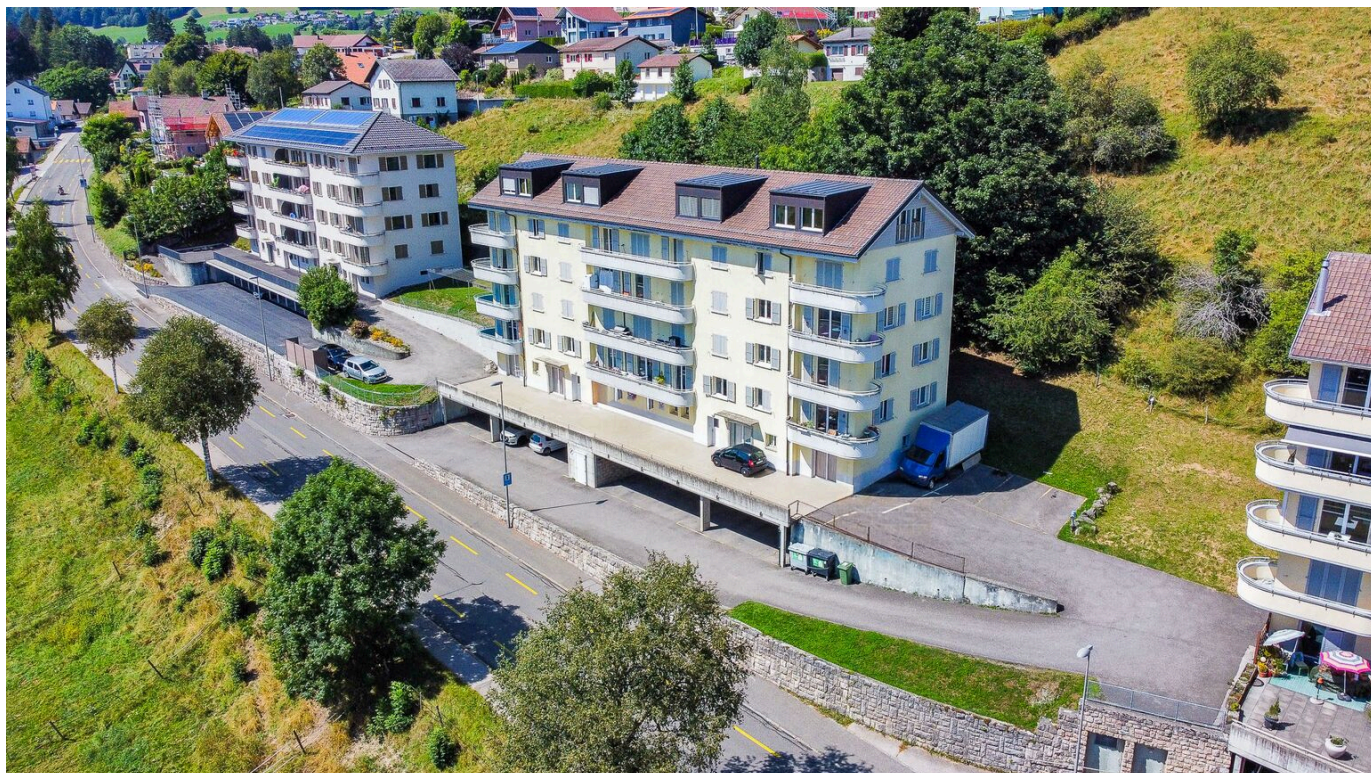
Vue aérienne du bâtiment
