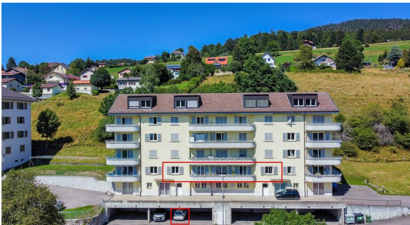
Vue aérienne du bâtiment
