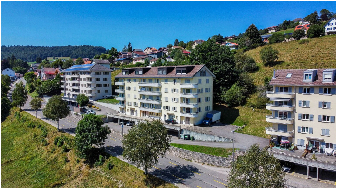
Vue aérienne du bâtiment
